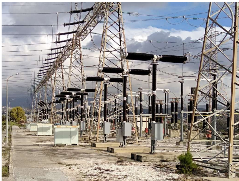
Εικόνα 8 – Διακόπτες 400 kV.
