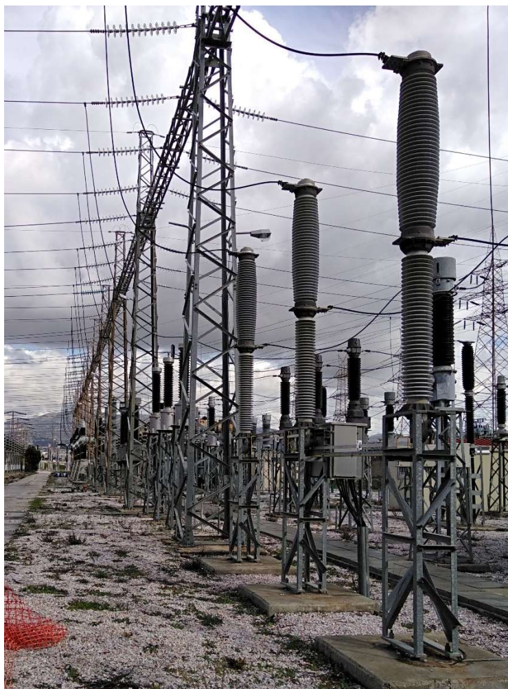
Εικόνα 7 – Διακόπτες 150 kV.
