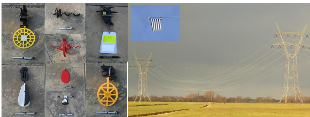
Εικόνα 7-2 (α) Τύποι σημαντήρων, (β) Γραμμή υψηλής τάσης με σημαντήρες τοποθετημένους σε τακτά διαστήματα (Πηγή: Prinsen et al. (2011))
